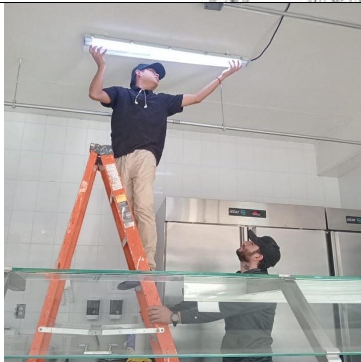
Trabajos de mantenimiento en infraestructura de la Facultad de Filosofía
