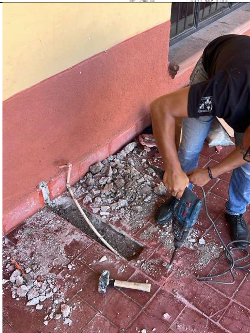
Trabajos de mantenimiento en infraestructura de la Facultad de Filosofía.
