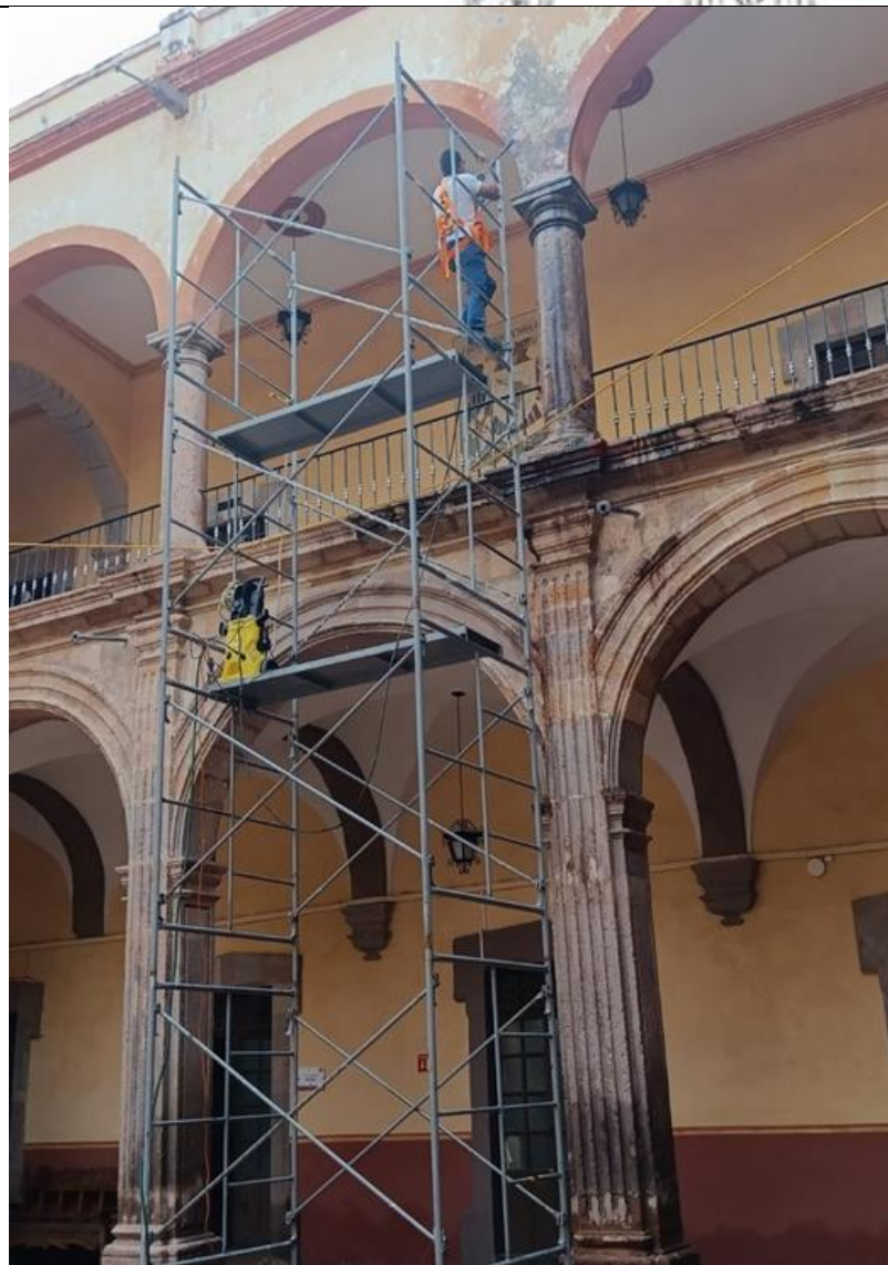
Limpieza de cantera por medio de cepillo de raíz con jabón neutro y agua, posteriormente limpieza a presión con hidro lavadora.
