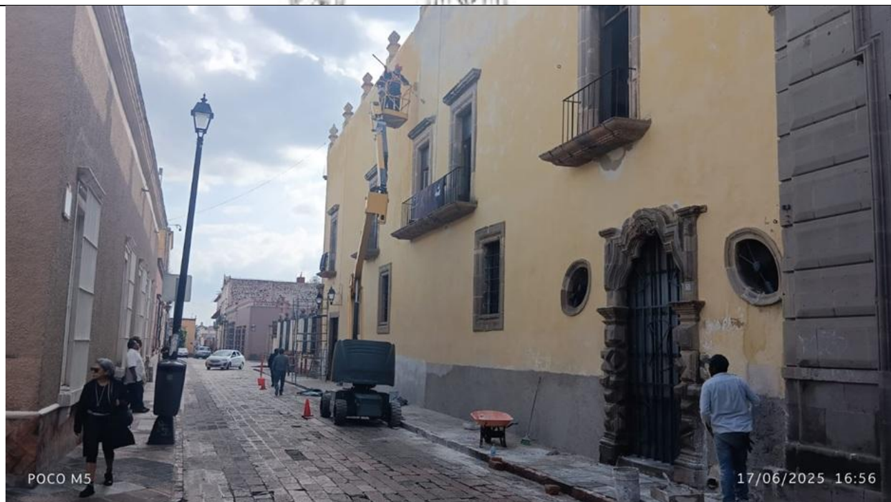
Durante los trabajos de restauración de Fachada Antigua del Campus Centro Histórico en calle 16 de septiembre.
