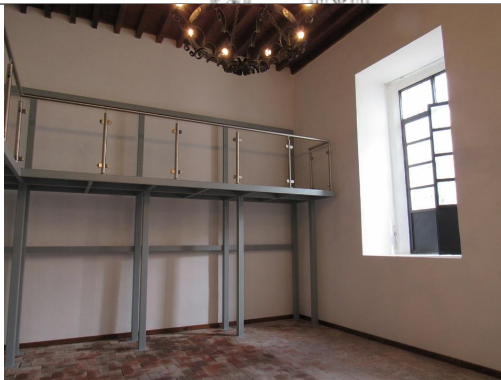
Después de la intervención de restauración del Salón de los candelabros.
