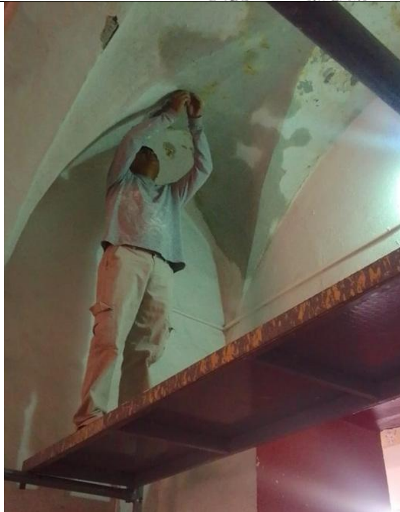
Trabajos mantenimiento de restauración de aplanado en bóvedas con mortero de cal.
