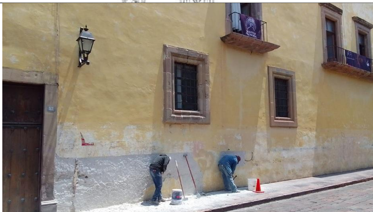
Supervisión de trabajos de restauración de Fachada Antigua del Campus Centro Histórico en calle 16 de septiembre.
