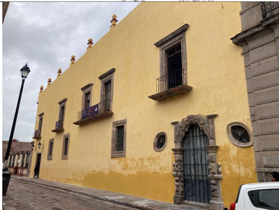
Restauración de Fachada Antigua terminada.
